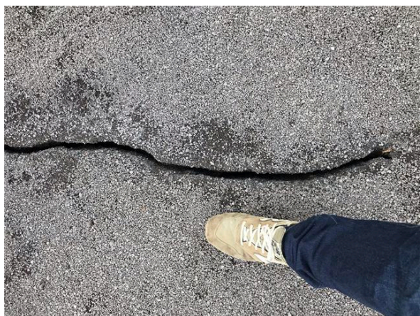
Aspecto de las grietas de la plataforma, previamente a la materialización de los testigos (14/05/2020)
